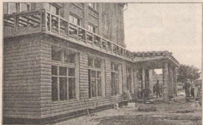
В рамках губернаторской программы «75x75» в НСШ проводится капитальный ремонт.
