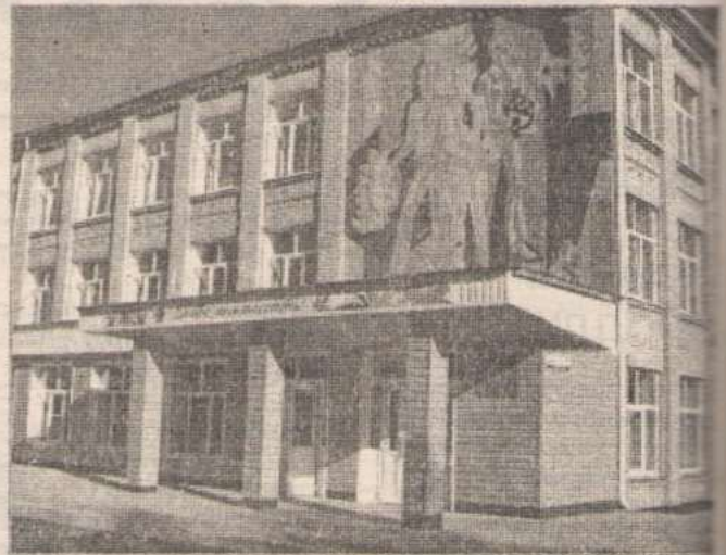
Новичихинская НСШ была отремонтирована по губернаторскому проекту.
