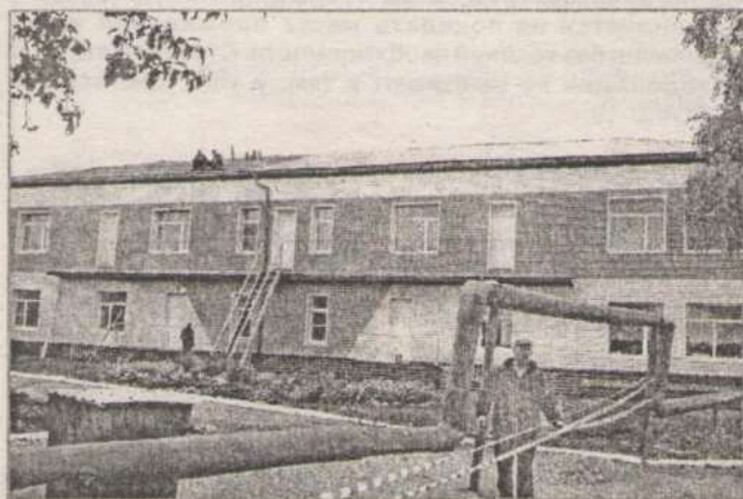
Завершатся ремонт кровли в детсаде «Солнышко».
